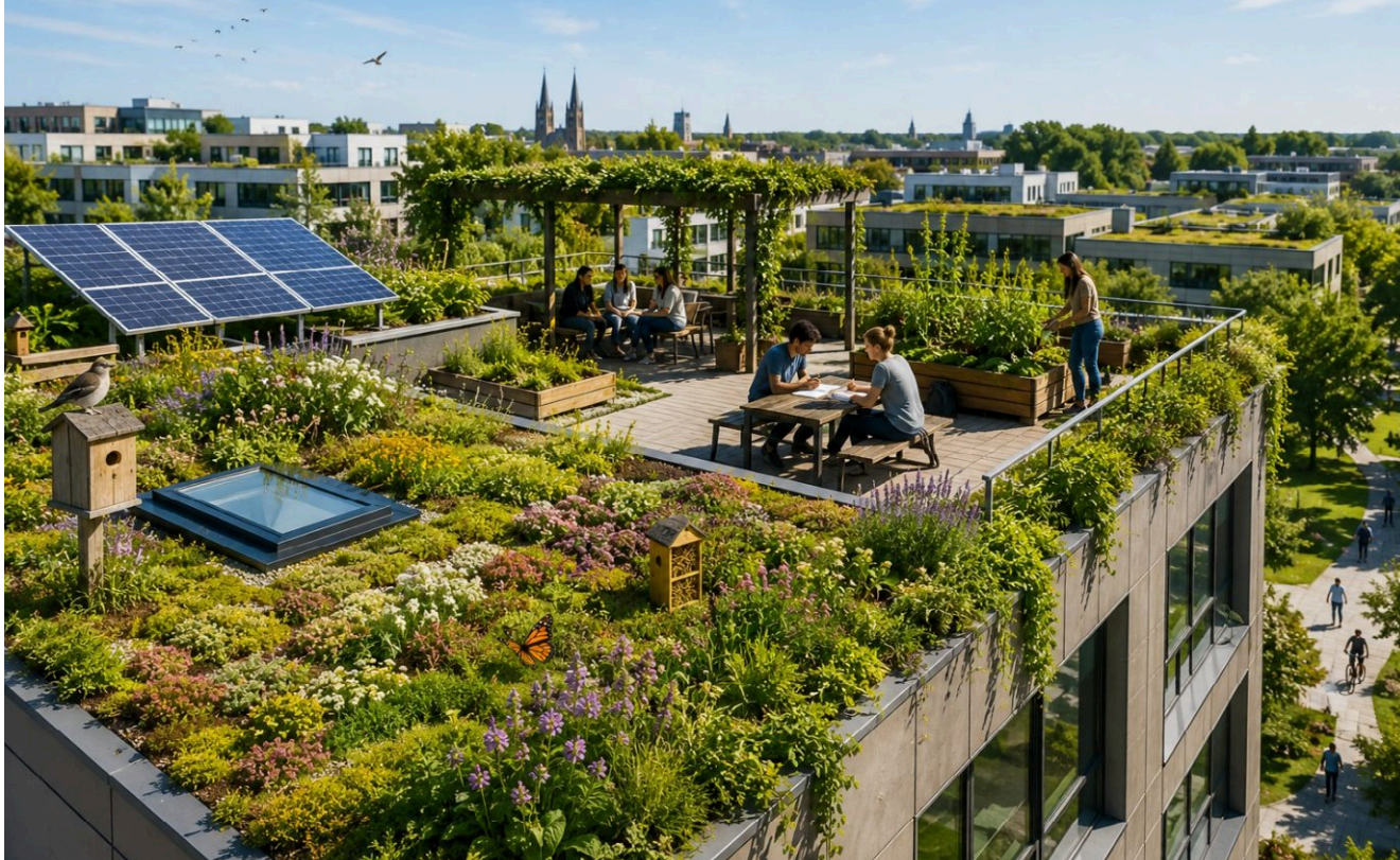
Przykład zielonego dachu i ogrodu dachowego
